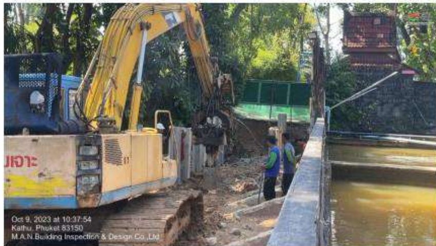
เสาเข็มที่ได้ทำการเจาะนำและกดโดยใช้ Vibro Hammer แทนการใช้ตอกโดยปั้นจั่น
