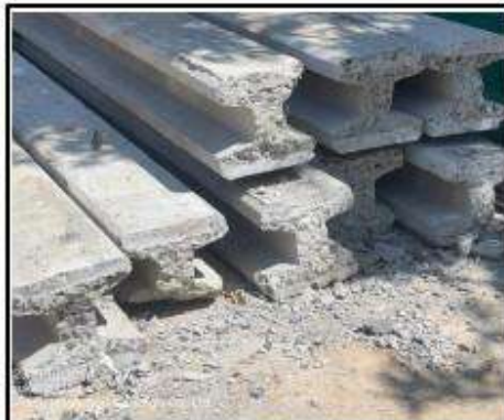
ตัดเสาเข็มก่อนทำการตอก
